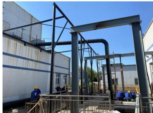
图 2 不减产、不停产更换提升管路施工现场
