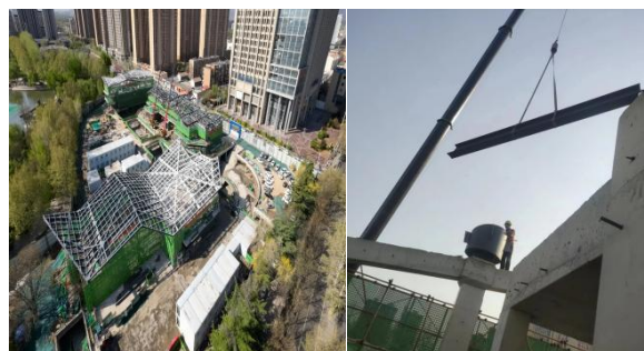
图5 钢结构施工过程中照片
