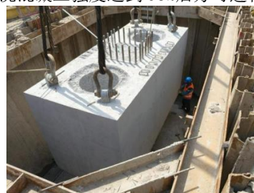
图6 承台吊装就位实景图
