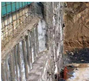
图1 排桩支护现场图
