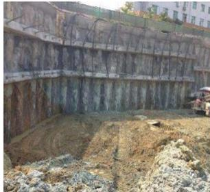
图3 桩锚结构现场图
