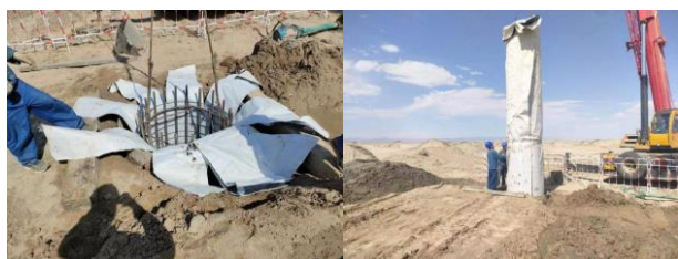
图 6 土工布袋安装示意图
