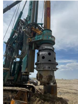
图 3 旋挖钻连接驱动套
