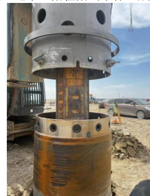
图 4 旋挖钻机连接护筒
