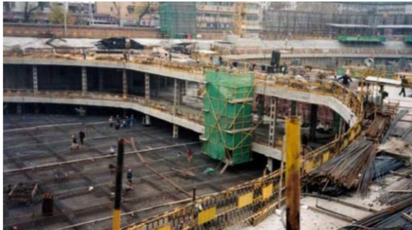
图 1 多层地下室且周边环境很复杂的深基坑
