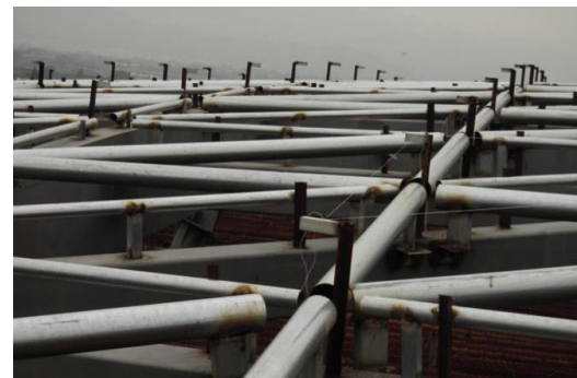
图 5 幕墙龙骨表面弧线定位装置
