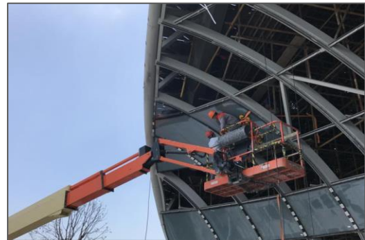
图 4 曲面玻璃幕墙安装
