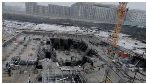
图 1 冬季基础施工工况图
