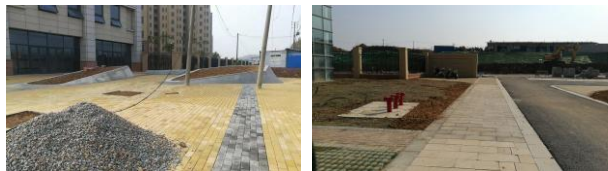
图5 现场透水砖铺装
