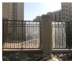
图7 围墙建成照片
