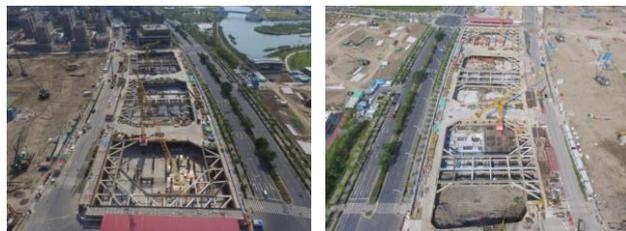
图 9 基坑东西同步施工现场照片
