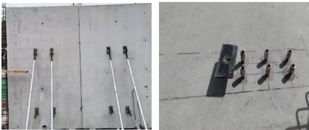
图 8 墙构件可调节斜支撑控制措施:墙构件标高可调节托盘
