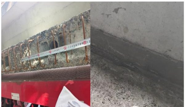
图 10 墙构件底部喇叭口:浇筑成型的水平接缝节点混凝土
