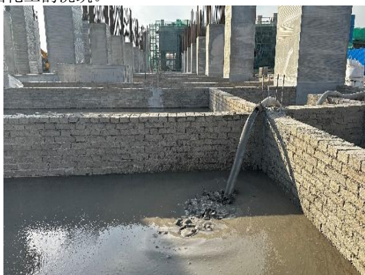
图8 流态固化土浇筑
