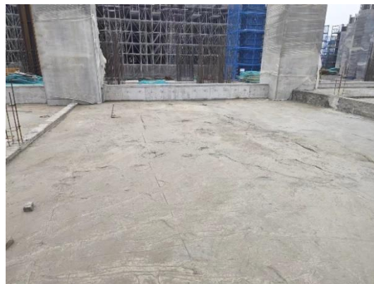
图 13 养护完成后的流态固化土
