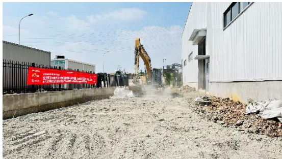
图5 撒布 GFS 粉体固化剂并与淤泥拌合
