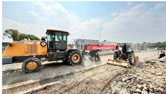
图5 撒布 GFS 粉体固化剂并与淤泥拌合
