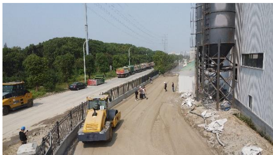
图7 单钢轮压路机震动碾压
