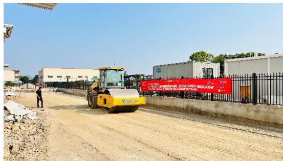
图7 单钢轮压路机震动碾压
