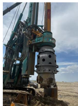
图 3 旋挖钻连接驱动套
