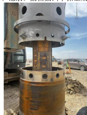
图 4 旋挖钻机连接护筒
