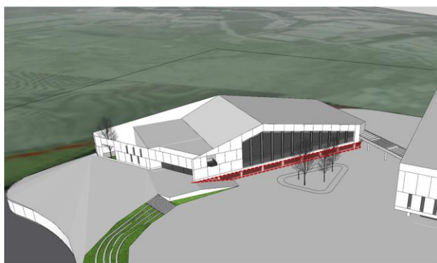
图8 游泳馆外观(隔震层)
