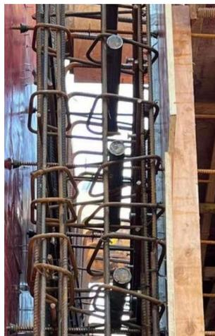
图6 铁套管注入黄油
