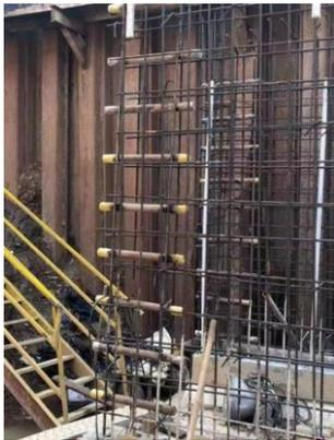
图8 铁套管排架预埋并固定
