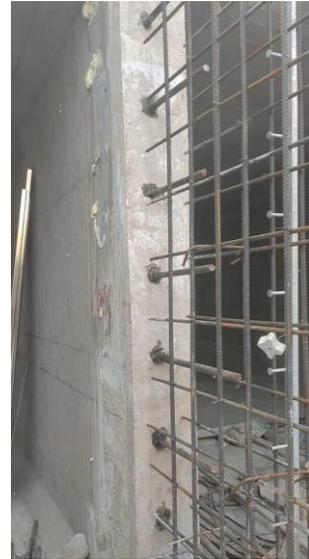
图10 传力杆安装完毕进行下节施工
