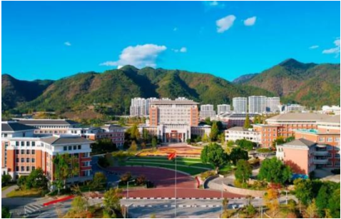
图 5 图书综合楼及教学区实景
