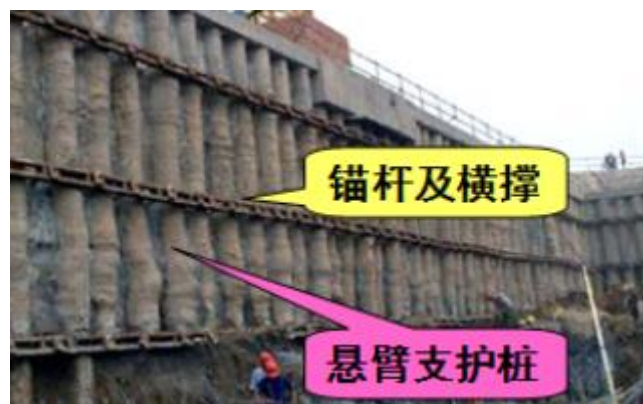
图1 土层锚杆示意图
