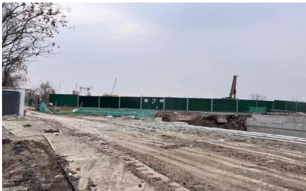
图2 市政工程现场施工图
