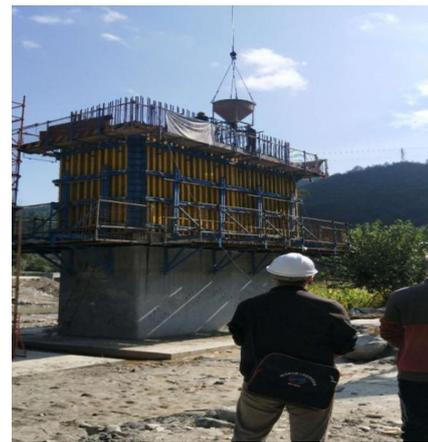
图 9 第二次浇筑混凝土
