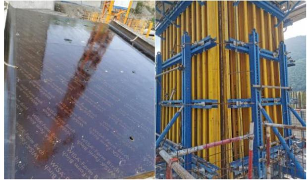
图 2 模板制作及安装现场图
