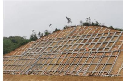
图6 格构梁浇筑成型
