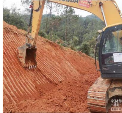
图 4 边坡刷坡成型
