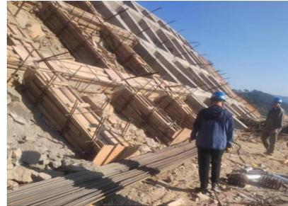
图5 格构梁模板安装
