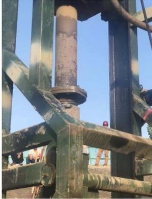
图 8 钻机导管安装
