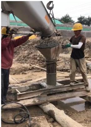
图 9 拆除导管
