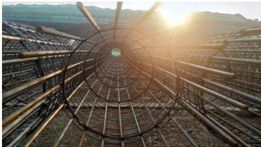
图 3 钢筋笼焊接完成
