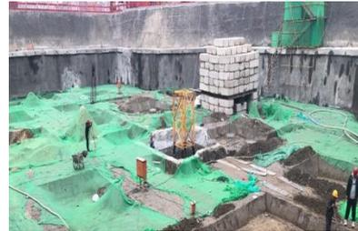
图 12 抗拔承载力检测
