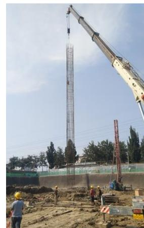
图 7 汽车吊吊放钢筋笼
