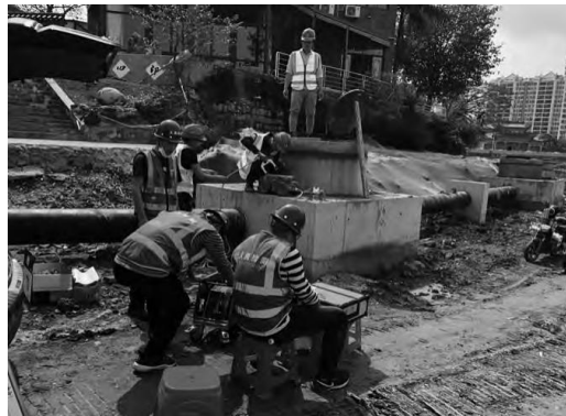
图1 CCTV检测现场
