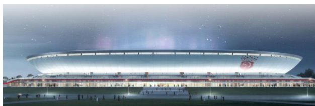
图1 浦东足球场的建筑外立面
