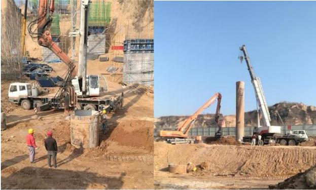
图6 加长加厚钢护筒振入及拔出示意图
