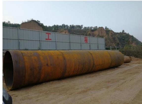
图 5 定制加长加厚钢护筒
