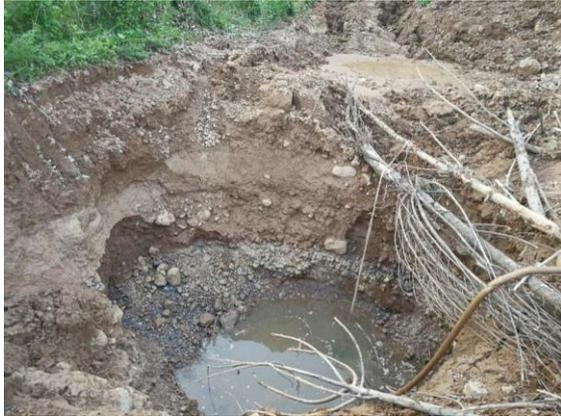
图 4 集水坑抽排浅层滞水示意图
