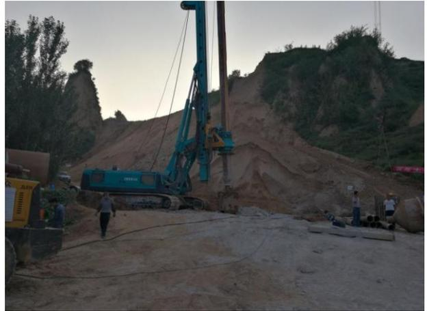
图 2 旋挖钻在半山坡干孔正常作业
