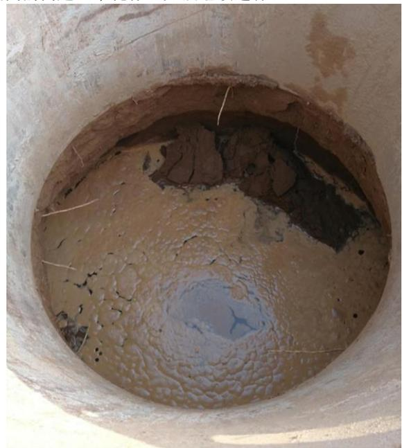
图 3 谷底桩孔遇地下浅层滞水出现塌孔
