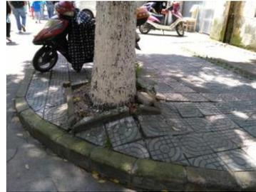
图8 浅层树根引起的人行道不平整
