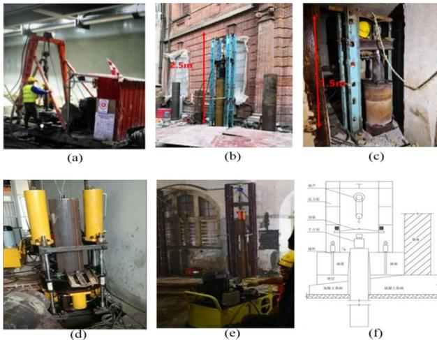
图6 (a) 锚杆静压桩托换施工(含托盘结构); (b) 常规静压桩施工; (c) 超净空锚杆静压桩; (d) 抱箍式锚杆静压桩施工; (e) 上压式锚杆静压桩; (f) 上压式锚杆静压桩原理示意图
