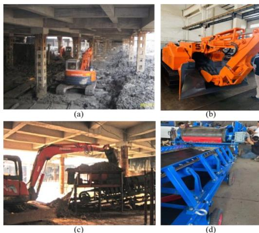
图 13 (a) 传统挖机翻运土方; (b) 新型长距离取土运土挖运一体履带斗装载机; (c) 传统挖机与皮带机合作输送运土; (d) 新型长距离皮带可拼接的皮带运输机
