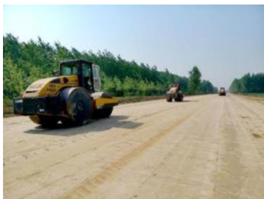
图 2 路基压实施工
