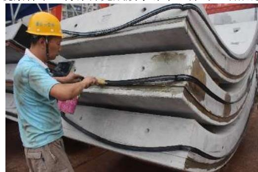
图 7：粘贴材料涂刷胶粘剂图
