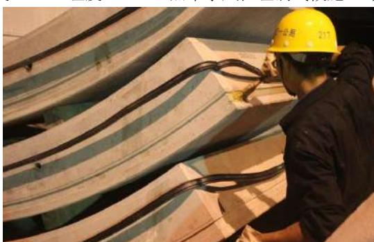
图 6：管片涂刷胶粘剂图
