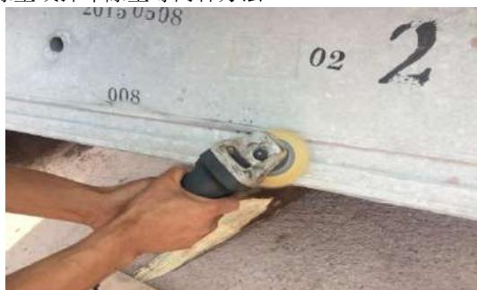
图 4：打磨除尘图
