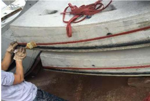
图 11：挡水条安装图
