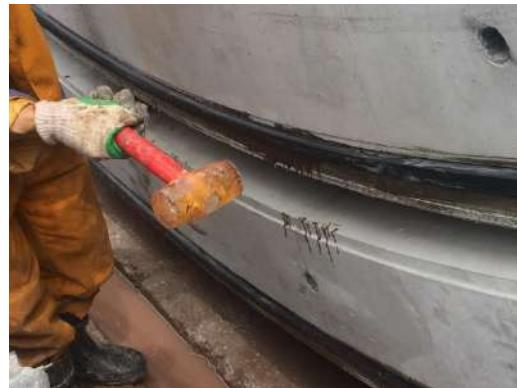
图 9：橡胶锤敲击粘贴材料图
