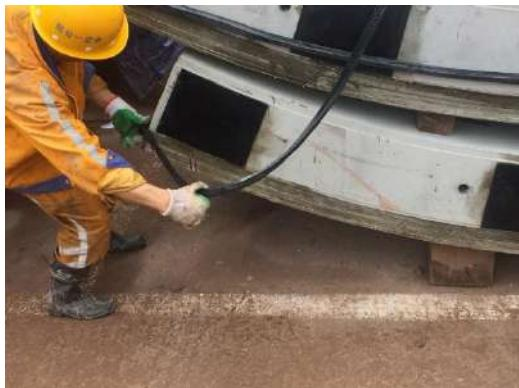
图 8：弹性橡胶密封垫安装图
