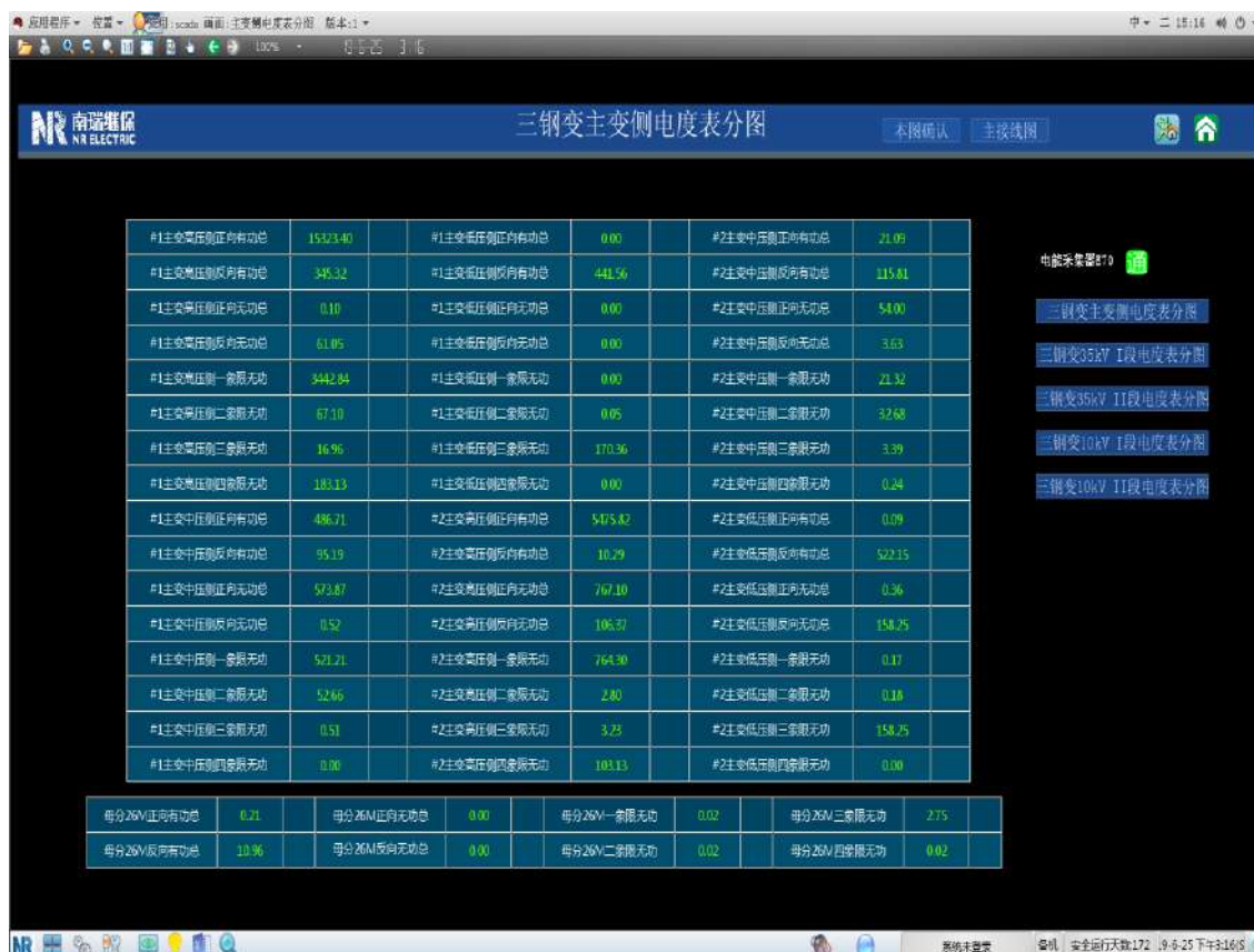
图5 变电站主变侧电表表
