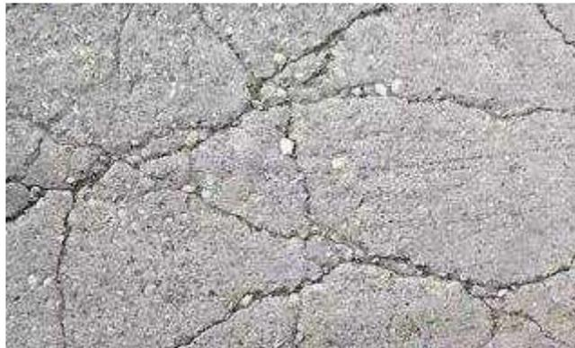
图2 干缩裂缝
