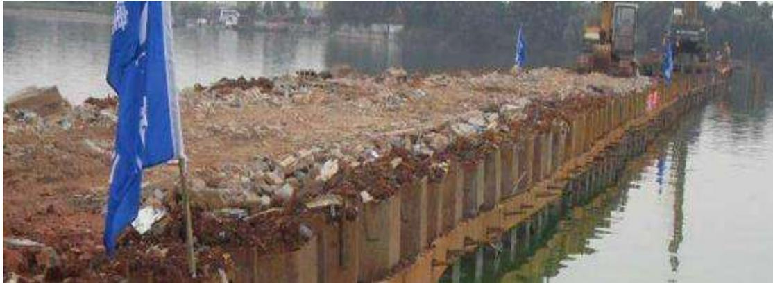
图1 钢板桩围堰
