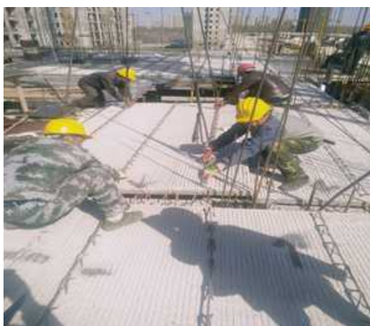
图 10 叠合板现场吊装示意图
