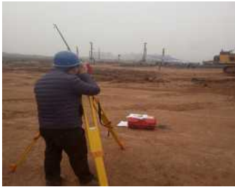
图 2 轴线、桩位测量
