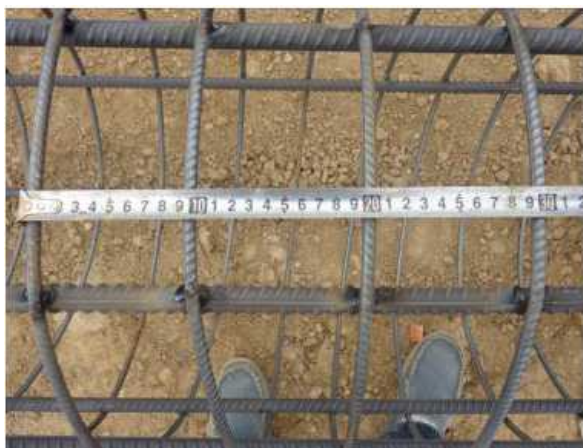
对钢筋笼的加密区和箍筋间距实测
