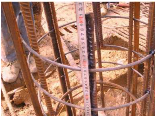
钢筋笼上下两节笼单面搭接焊验收
