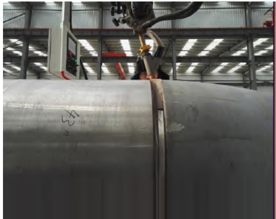
图4 焊接操作过程
