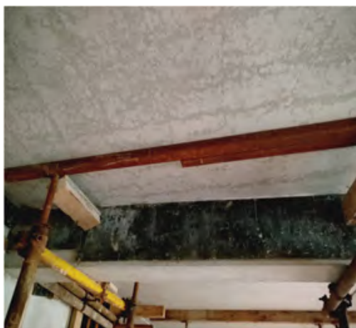
图 11 板与梁缝隙封堵示意图
