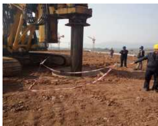
图 5 钻进成孔
