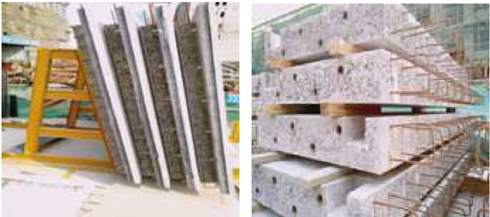
图 5 装配式构件堆放示意图
