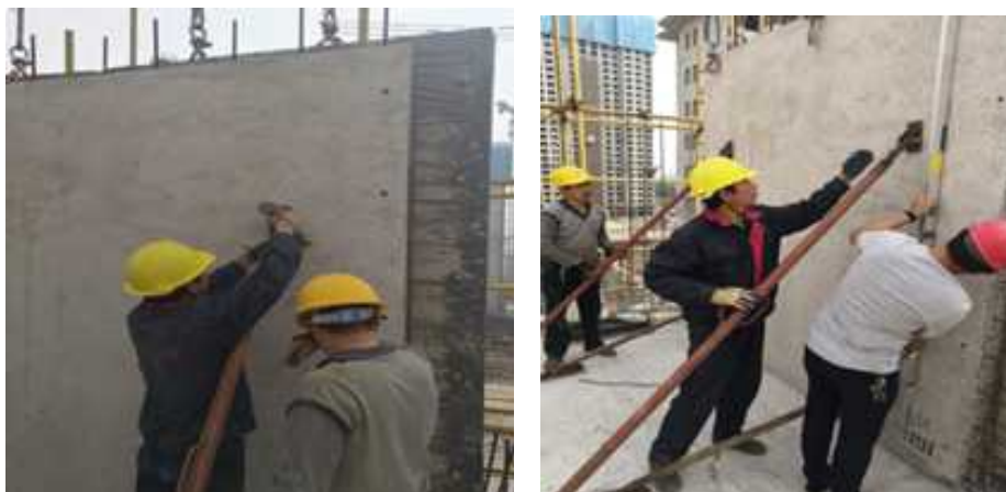
图9 斜撑安装及垂直度调整示意图
