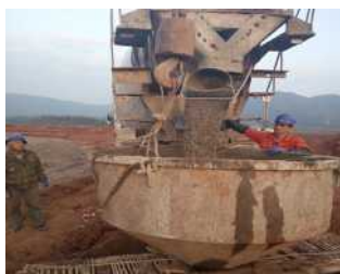
图 13 混凝土浇筑
