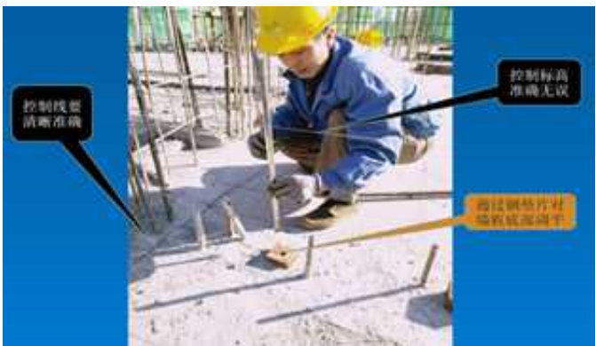
图 6 墙板底部调平示意图
