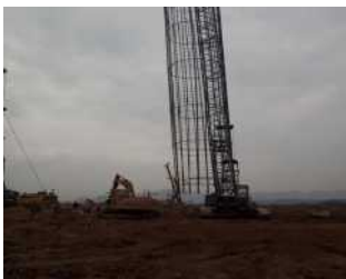
图 9 钢筋笼吊装
