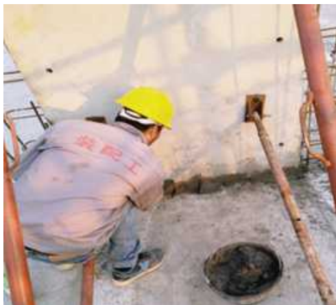
图13 座浆施工示意图
