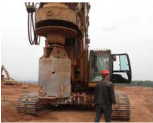
图 4 桩机调整就位
