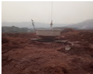
图 12 导管、斗安装
