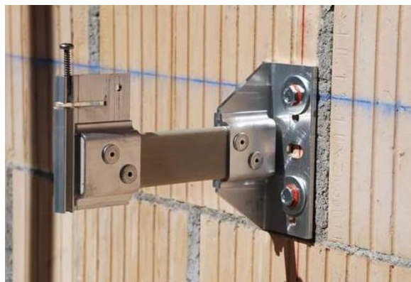
图3 不透明维护板支撑系统
