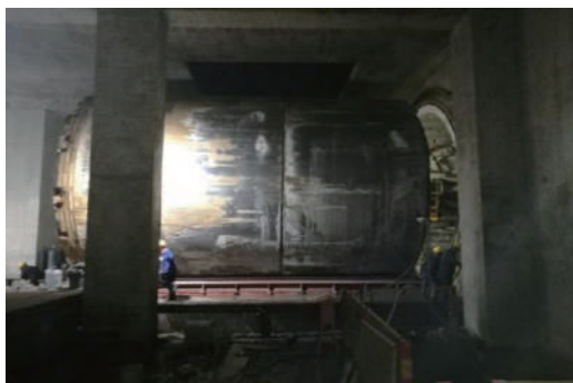
图 5 盾构机接收并安全上到接收托架
