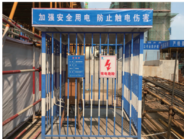
图8 工具式临时用电隔离栏
