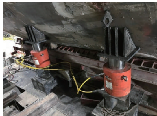
图11 顶升盾构机及托架
