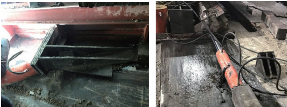
图12 盾构主机平移
