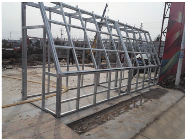
图 1 定型化钢构结构
