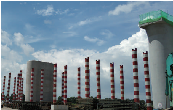
钢管柱安装
