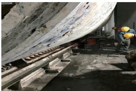
图 7 接收架与盾构机焊接成一体
