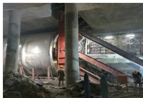
图15 盾构主机与后配套连接，调试盾构机
