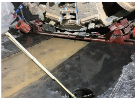
图 6 钢板上涂抹液压油
