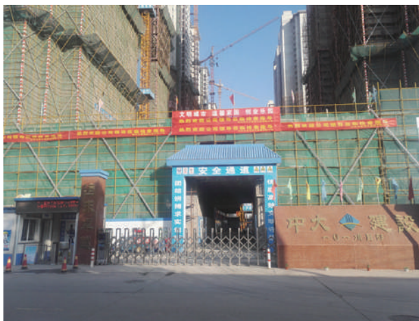
图 2 定型化钢构柱伸缩式大门体系
