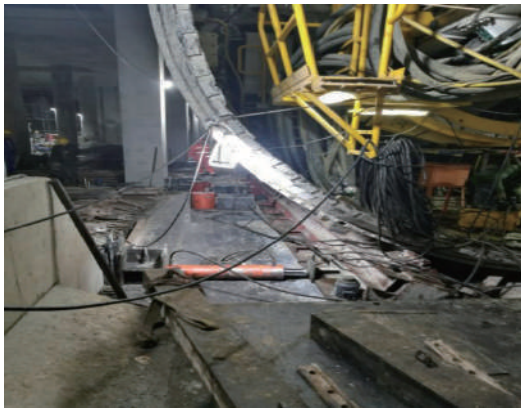
图9 盾构主机及托架侧移
