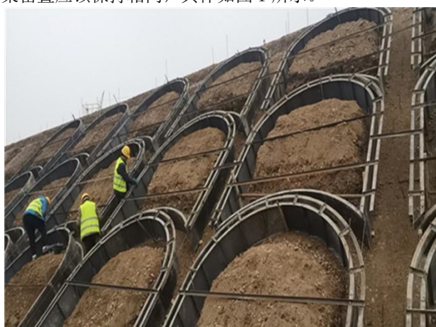
图 1 拱形骨架护坡施工
