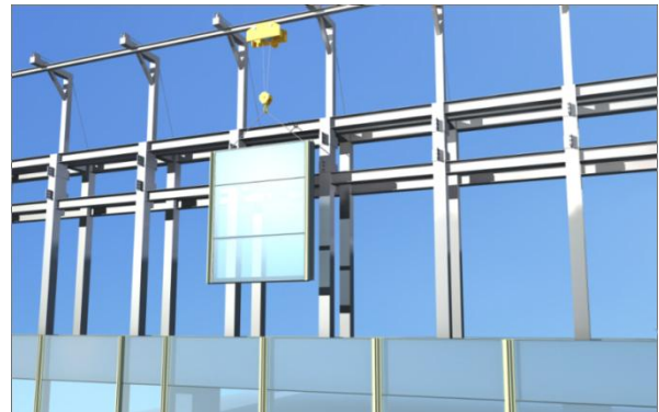
图5 轨道吊装示意
