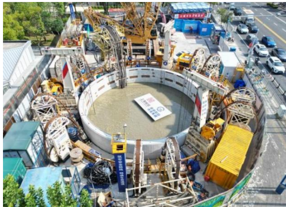
图 3 施工现场实景图
