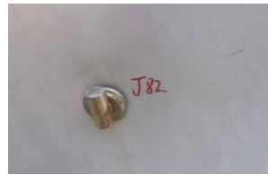
图 5 建筑物监测点布设示
