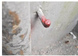
图 4 建筑物监测点布设示例
