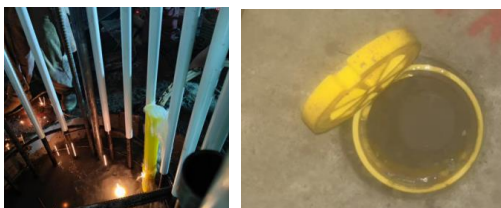
图 7 桩体深层水平位移布设实景图
