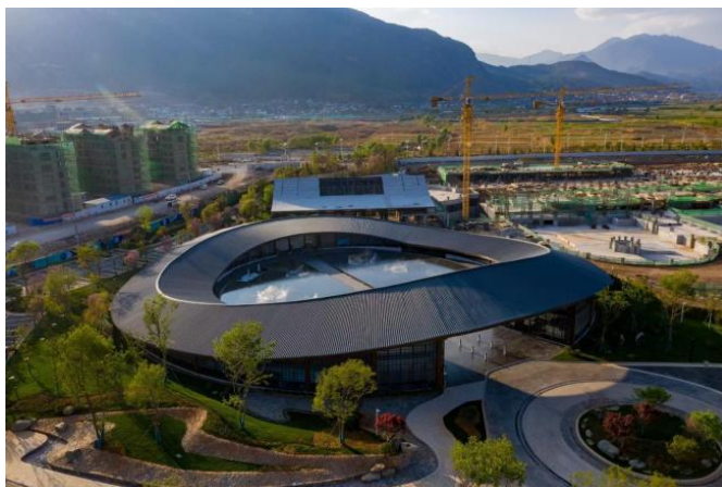
图3 建设过程实景
