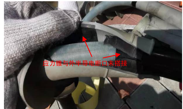
图 18 电缆终端应力锥安装尺寸明显错误
