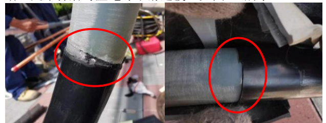
图 19 电缆外半导电断口工艺不良
