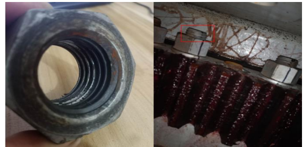
图7 螺栓润滑脂涂抹情况
