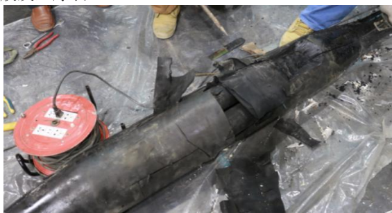
图9 接头防水胶固化情况
