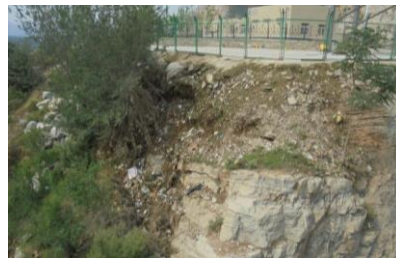
图6 总干渠漕河渡槽出口拦网清出杂物
