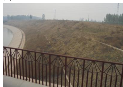
图8 总干渠唐县段岸坡枯草及植物秸秆
