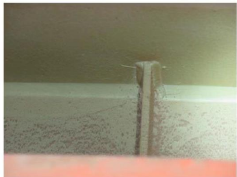
图 5 3-4 线/D 轴吊车梁上翼缘与腹板、加劲肋连接焊缝开裂，延伸至腹板母材
