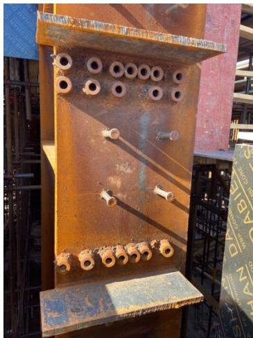
图9 连接板与接驳器现场图片
