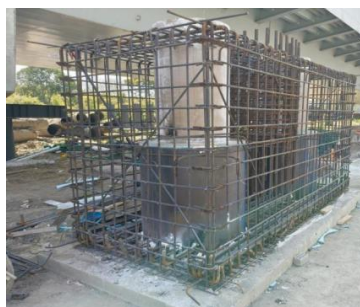
图4 预制承台钢筋模板施工实景图
