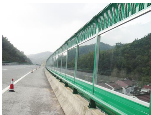
图 2 弧形顶透明复合声屏障
