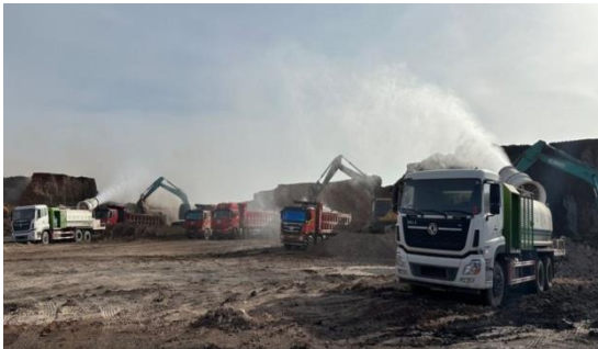
图4 清运过程抑尘措施
