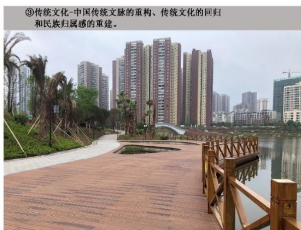
图3 项目实景图-滨水步道
