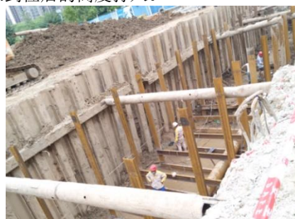
图4 钢板桩施工
