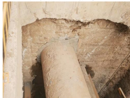
图6 管道与检查井连接填充
