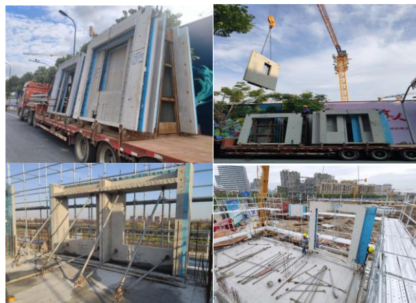
图3 双面叠合夹心保温外墙板安装
